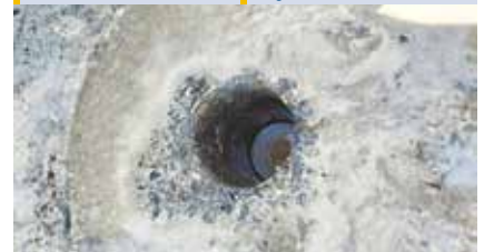
Réalisation d'un carottage dans une chaussée
