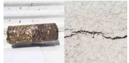
Carotte d'une chaussée
