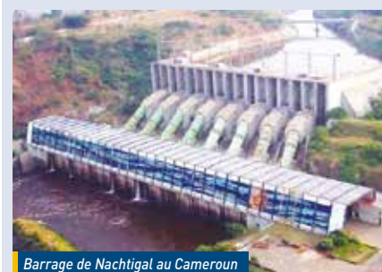
Barrage de Nachtigal au Cameroun
