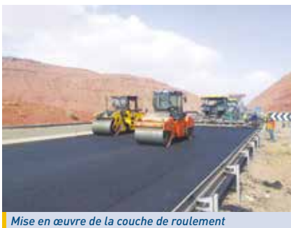
Mise en œuvre de la couche de roulement
